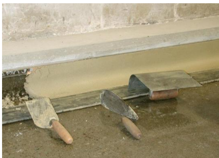
Obr. 4: Ukončující obkladová lišta jako horní hrana soklu
