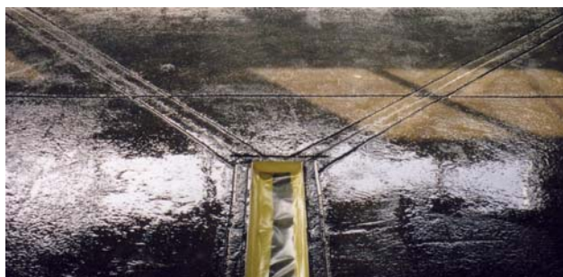
Obr. 14: Spára z betonáže na styku spádů (s kotvícími drážkami)
