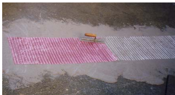
Obr. 15: Laminování skelnou tkaninou v oblasti spáry z betonáže
