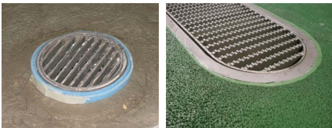
Obr. 11: Podlahová vpust' a žlab s elastickým napojením na podlahový systém
